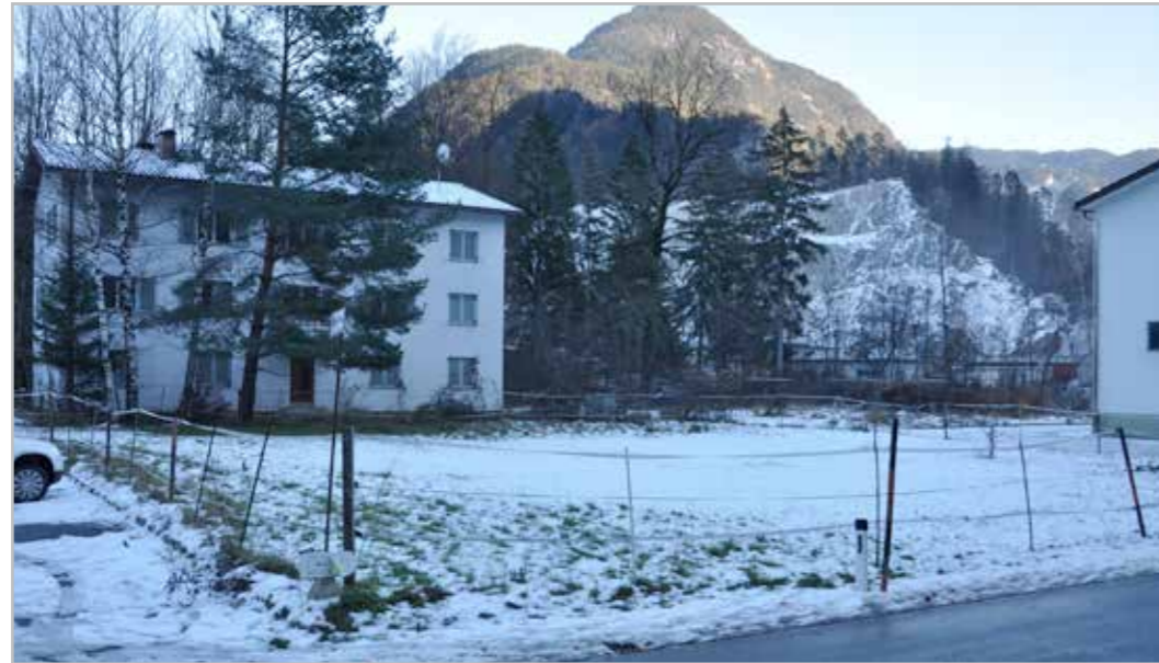
Hier in Brunnenfeld soll das neue Altstoffsammelzentrum gebaut werden.
